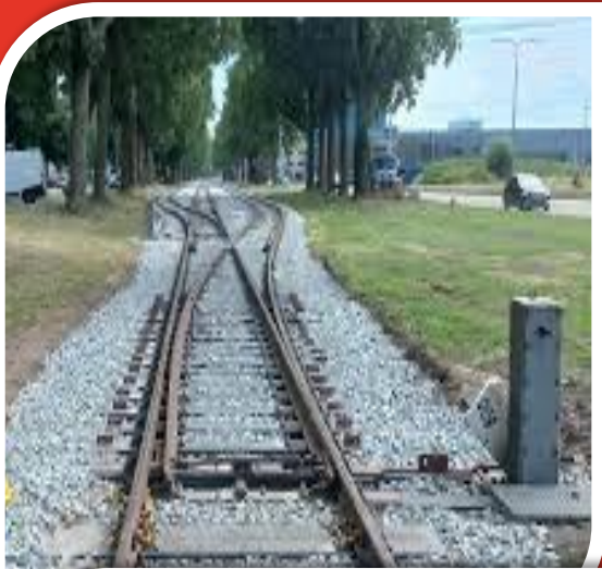
Spooreigenaar 650 km industriespoor in Nederland
